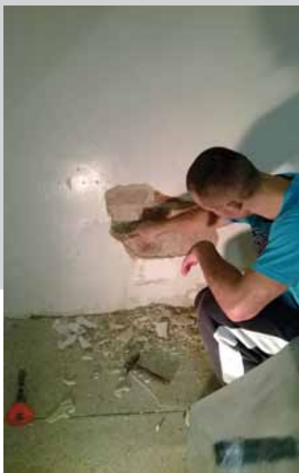
Remont – potrzebny od zaraz / fot. Katarzyna Dębiec
