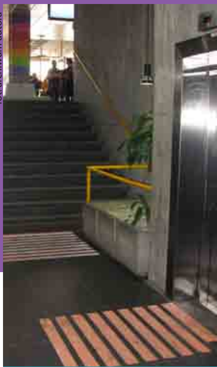
Oznakowania windy i schodów
