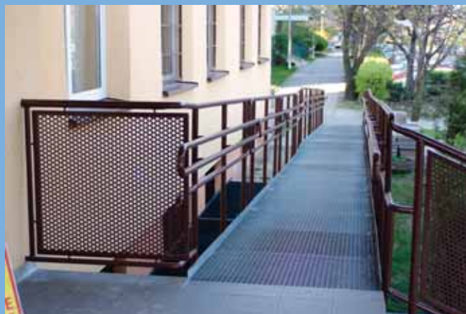
Podjazd do domu studenckiego „Merkury” UEK
